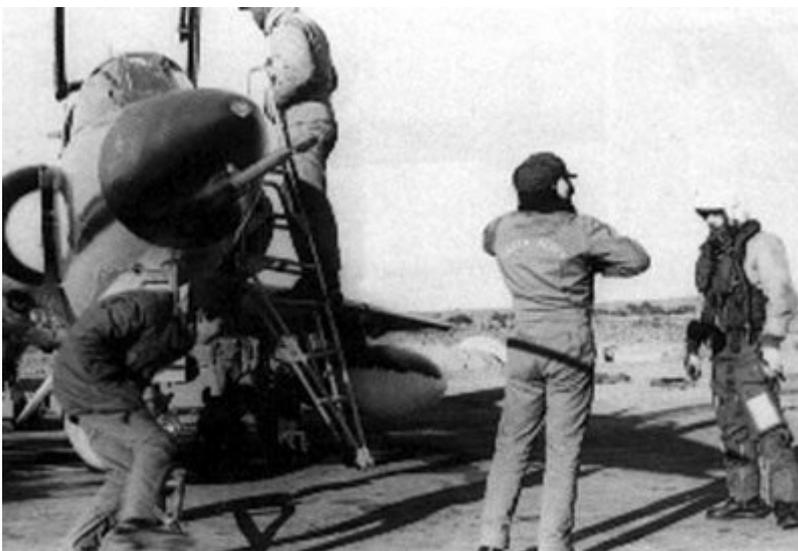
Mecánicos realizando al inspección previa al vuelo y llegada del piloto
